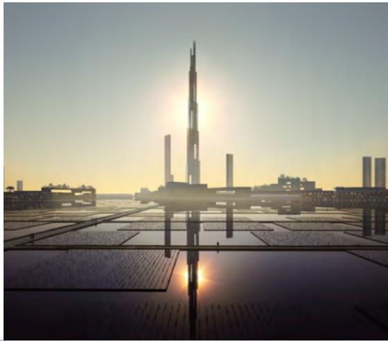
をなす支柱に台形状の空間スペースを六角形に組み合わせていく形態で、それぞれの台形構造は中をらせん状にし空気の導線を確保し、地震、台風等の気候変動にも十分耐えられる設計だといえます。建物内部には住宅、商業施設を上空1,600mまで垂直方向に展開する予定だそうです。
