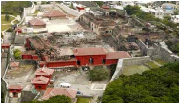
左は火災で正殿などが焼失した首里城 右は2012年10月の様子
