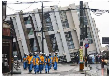
安田教授は、揺れによって地面と建物の接合部で、杭の頭が破断されたり、抜けたりしていて、杭の本体は地面の中に残っているのではないかとみています。
